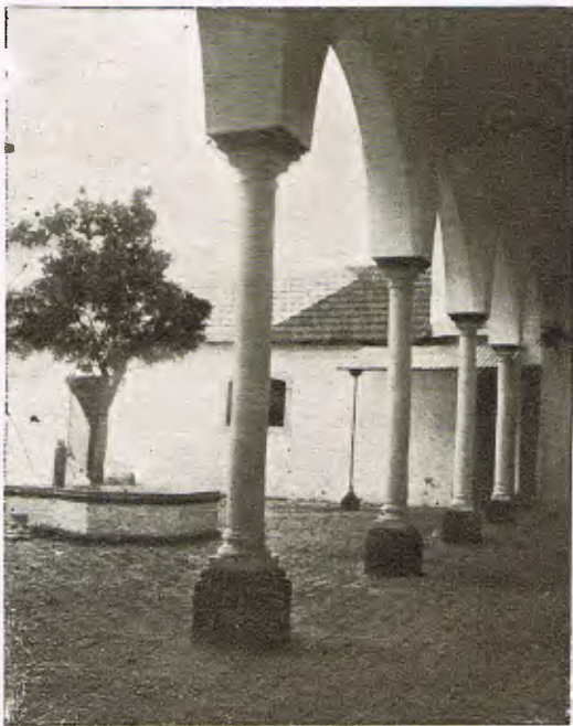
GALERÍA DE UN PATIO DEL CASERÍO
