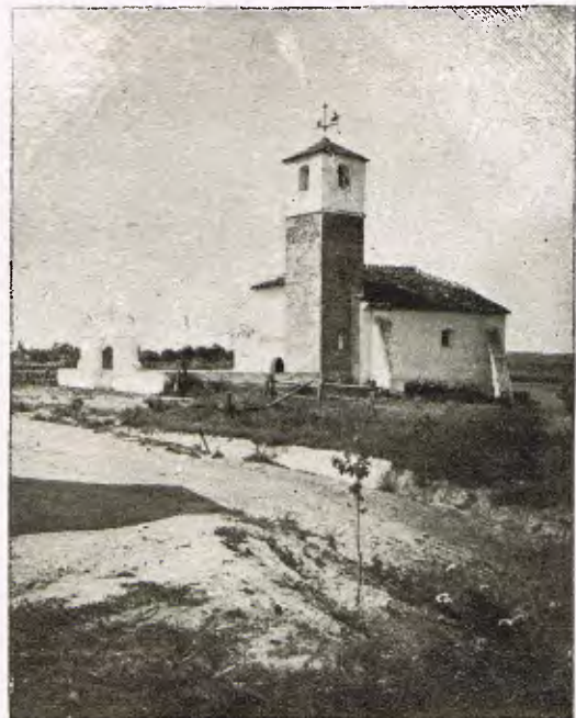
LA CAPILLA DEL CASERÍO
